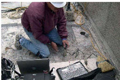
Figura 16. Las pruebas de ultrasonidos se realizan en una losa estructural de hormigón para ayudar a determinar la profundidad del deterioro. En este método, se introduce un breve impulso de energía en la estructura y un transductor montado en la superficie impactada de la estructura recibe las ondas de entrada reflejadas o los ecos. Estas ondas se analizan para ayudar a identificar fallos y posible deterioro dentro del hormigón.
