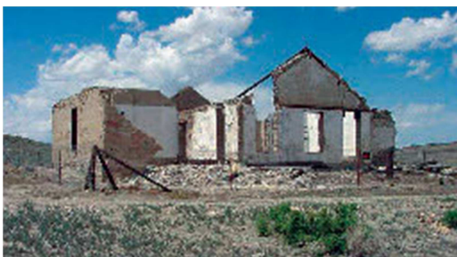
Figura 2. Chatterton House fue el hogar del comerciante de correos en Fort Fred Steel, Wyoming, una de las fortalezas establecidas en la década de 1860 para proteger el Union Pacific Railroad. Las paredes de la casa se construyeron con áridos y cal, sin cemento. El uso de este material presenta retos especiales de conservación.
