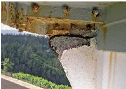
Figura 12. El faro de hormigón en la Estación de Luz de Kilauea Point, Kilauea, Kauai, Hawaii, fue construido alrededor de 1913. El hormigón, que fue una mezcla de buena calidad y alta resistencia en su día, está en buenas condiciones después de casi cien años de servicio. El deterioro en forma de desprendimiento relacionado con la corrosión de las armaduras de acero se ha producido principalmente en áreas de mayor ornamentación, como bandas y soportes de proyección (ver foto de primer plano).
