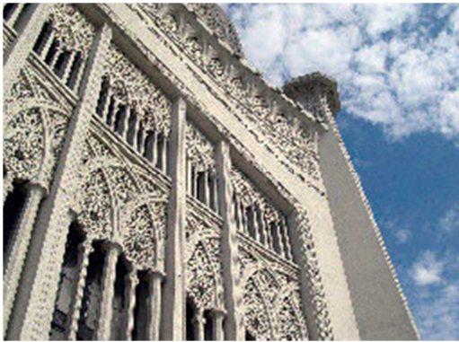
Figura 4. Los paneles de hormigón altamente ornamentales en la fachada exterior de la Casa de Adoración de Baha'i en Wilmette, Illinois, ilustran el trabajo del fabricante John J. Earley, conocido como "el hombre que hizo el hormigón hermoso".
