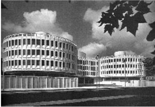
Figura 5. Después de la Segunda Guerra Mundial, los arquitectos e ingenieros aprovecharon las mejoras en la producción del hormigón, el control de calidad y los avances en prefabricados para diseñar estructuras como el edificio del Cuartel de la Policía en Filadelfia, Pensilvania, construido en 1961. Foto: Cortesía del Departamento de Policía de Filadelfia.
