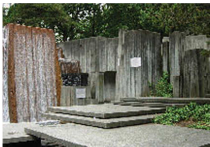
Figura 9. La fuente Ira C. Keller en Portland, Oregón, fue diseñada por Lawrence Halprin y construida en 1969. La fuente está construida principalmente con pilares de hormigón con texturas de tableros y elementos circundantes con dibujos geométricos, que facilitan el paso del agua. Fotografía: Anita Washko, Wiss, Janney, Elstner Associates, Inc.
