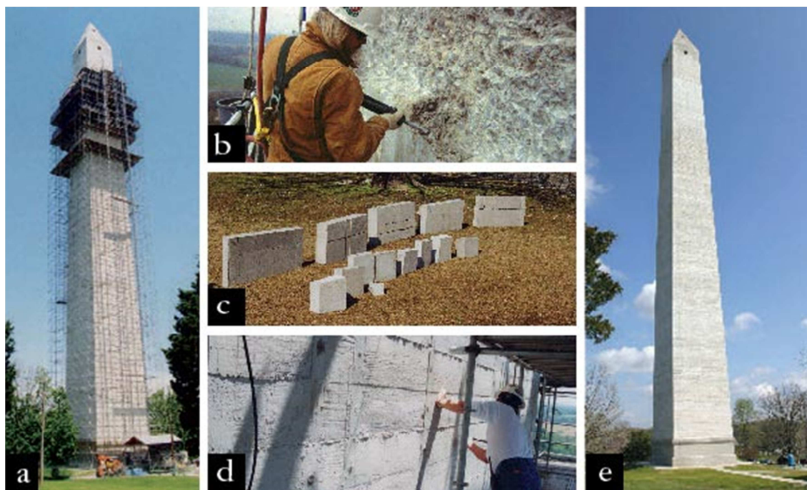
Figura 20. (a) El Monumento a Jefferson Davis en Fairview, Kentucky, construido desde 1917-1924, tiene 351 pies de altura y está construido de hormigón no reforzado. Las paredes del monumento tienen 8 pies de espesor en la base y 2 pies de espesor en la parte superior del muro. El acceso al monumento para la investigación se proporcionó mediante técnicas de rappel, mientras que los andamios apoyados y suspendidos se utilizaron para acceder al exterior durante las reparaciones. (b) El hormigón se deterioró severamente en lugares aislados, con desprendimientos y daños causados por la congelación y descongelación cíclica del agua atrapada. Además, las reparaciones anteriores se encontraban al final de su vida útil y se requirió la eliminación del hormigón deteriorado y las reparaciones anteriores fallidas. Se usaron pequeños martillos de trabajo para evitar daños al material adyacente al retirar el hormigón deteriorado. (c) Se realizaron muestras de campo para igualar el color, el acabado y la textura del hormigón original. Un desafío en la coincidencia de hormigón histórico es lograr variabilidad de apariencia. (d) La superficie completa después de las reparaciones muestra una variabilidad intencional de la superficie del hormigón para que coincida con el aspecto del original. Algunas imperfecciones del encofrado que normalmente se eliminarían al terminarse se dejaron intencionalmente en su lugar para replicar el acabado altamente variable del hormigón original. (e) El Monumento a Jefferson Davis después de completar las reparaciones en 2004. Fotografía e: Joseph Lenzi, Senler, Campbell & Associates, Inc.
