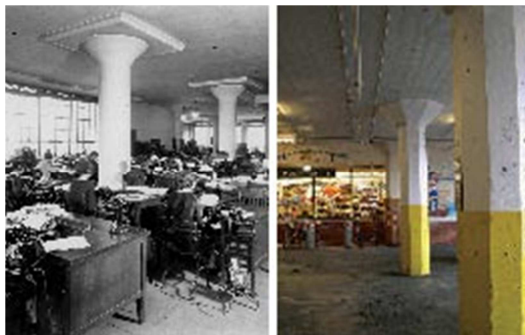
Figura 11. Tanto en una oficina (izquierda) como en un aparcamiento o en una tienda minorista (derecha), las estructuras de hormigón visto ayudan a caracterizar los interiores de estos edificios. Foto: Sociedad Histórica de Minnesota (izquierda).
