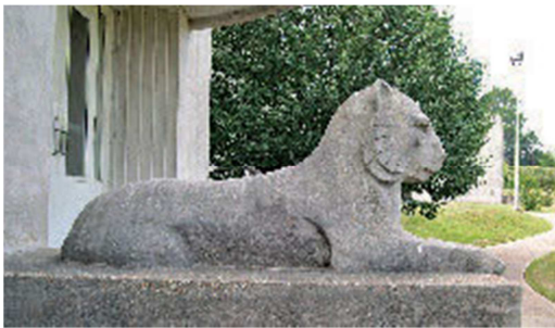
Figura 7. Los bajorrelieves detallados, así como las esculturas, como este león en la Escuela Bailey Magnet, podían usarse como ornamentación en edificios de hormigón. Los elementos esculturales de hormigón se fabricaban normalmente en moldes.
