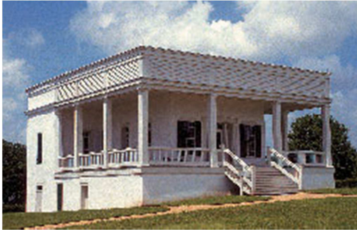
Figura 1. La casa Sebastopol en Seguin, Texas, es una casa de 1856 de estilo neogriego construida con hormigón de cal. El hormigón de cal o "limecrete" era un material de construcción popular, ya que se podía fabricar a bajo coste con materiales locales. En 1900, la ciudad tenía aproximadamente noventa estructuras de "limecrete", veinte de las cuales se conservan en la actualidad. Foto: Texas Parks and Wildlife Department.
