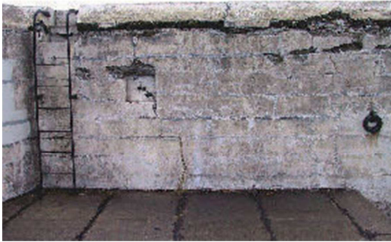
Figura 13. Fort Casey en Admiralty Head, Fort Casey, Washington, fue construido en 1898. Las líneas de elevación desde la colocación del hormigón son claramente visibles en las paredes exteriores y caracterizan el aspecto final.
